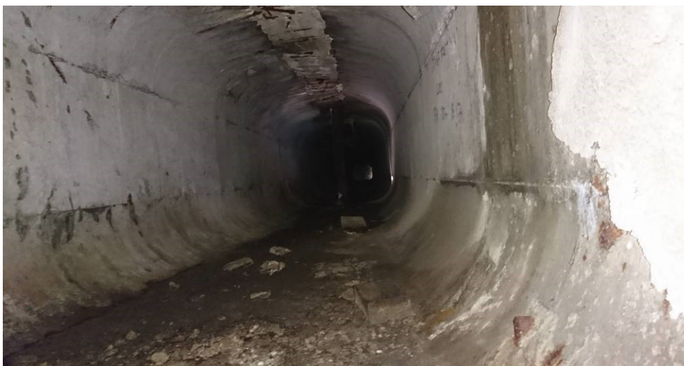
Obr.F41-504 Dutina mezi nosníky č.1 a č.2 v prvním poli. Pohled skrz dilatační spáru mezi čely nosníků č.1 prvního a druhého pole nad 2. (mezilehlou) podpěrrou, proti směru staničení,
