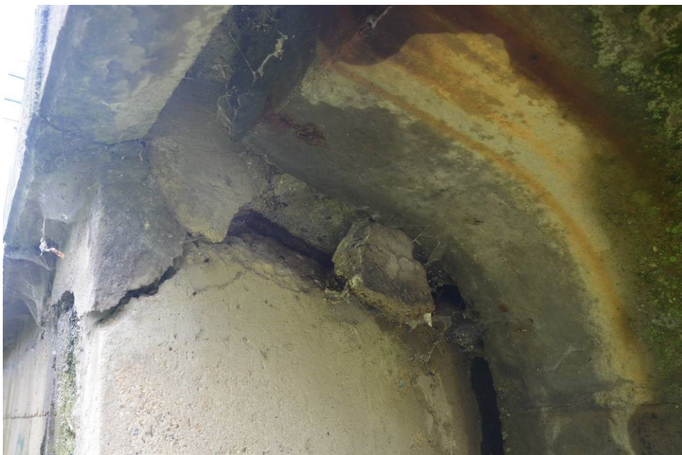
Obr.F41-58 Detail odtržení pravého konce závěrné zdi první podpěry, křetínské opěry. Pohled proti směru staničení a zprava doleva,
