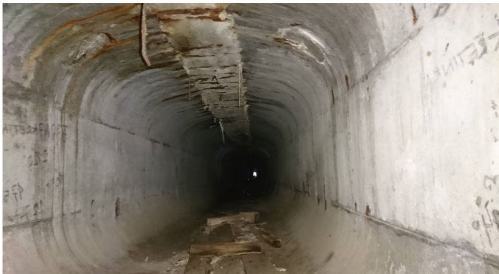
Obr.F41-505 Dutina mezi nosníky č.1 a č.2 ve druhém poli. Pohled skrz dilatační spáru mezi čely nosníků č.1 prvního a druhého pole nad 2. (mezilehlou) podpěrrou, ve směru staničení,
