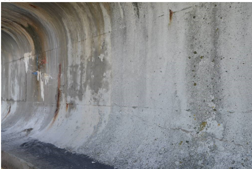
Obr.F41-40 Trhlina v místě zvedaného kabelového kanálku na levé fasádě (nosník č.1) na konci třetího pole. Pohled ve směru staničení a zleva doprava (proti vodě),
