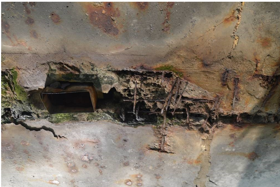
Obr.F41-63 Typický výtok z odpadní trouby mostního odvodňovače na mostě. Zde druhý levostranný odvodňovač ve druhém poli,
