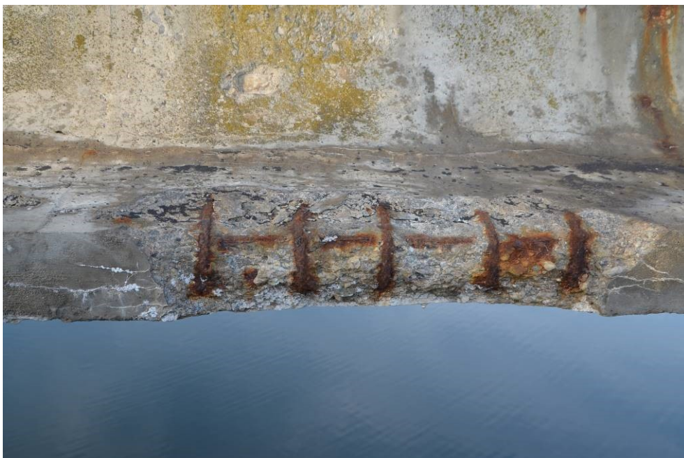
Obr.F41-51 Příklad poruchy dolní příruby nosníku č.8 ve třetím poli. Pohled zprava doleva (po vodě),
