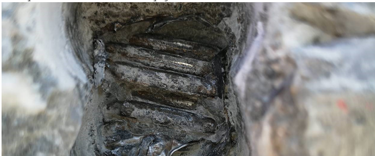
Obr.F41-406 Sonda S40 do zvedaného kabelového kanálku předpjaté výztuže vedeného ve stojině nosníku č.8 ve čtvrtém poli. Sonda provedena 2300 mm za začátkem nosníku a 630 mm nad podhledem nosníku,
