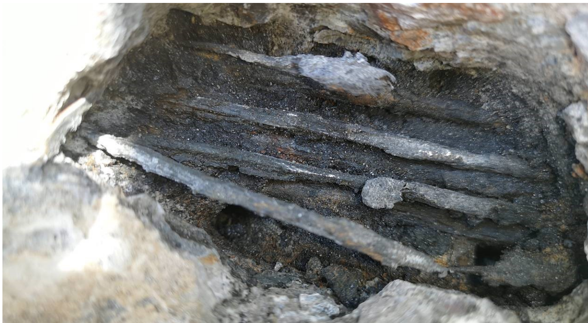
Obr.F41-409 Sonda S43 do zvedaného kabelového kanálku předpjaté výztuže vedeného ve stojině nosníku č.8 ve čtvrtém poli . Sonda provedena 4600 mm za začátkem nosníku a 650 mm nad podhledem nosníku,
