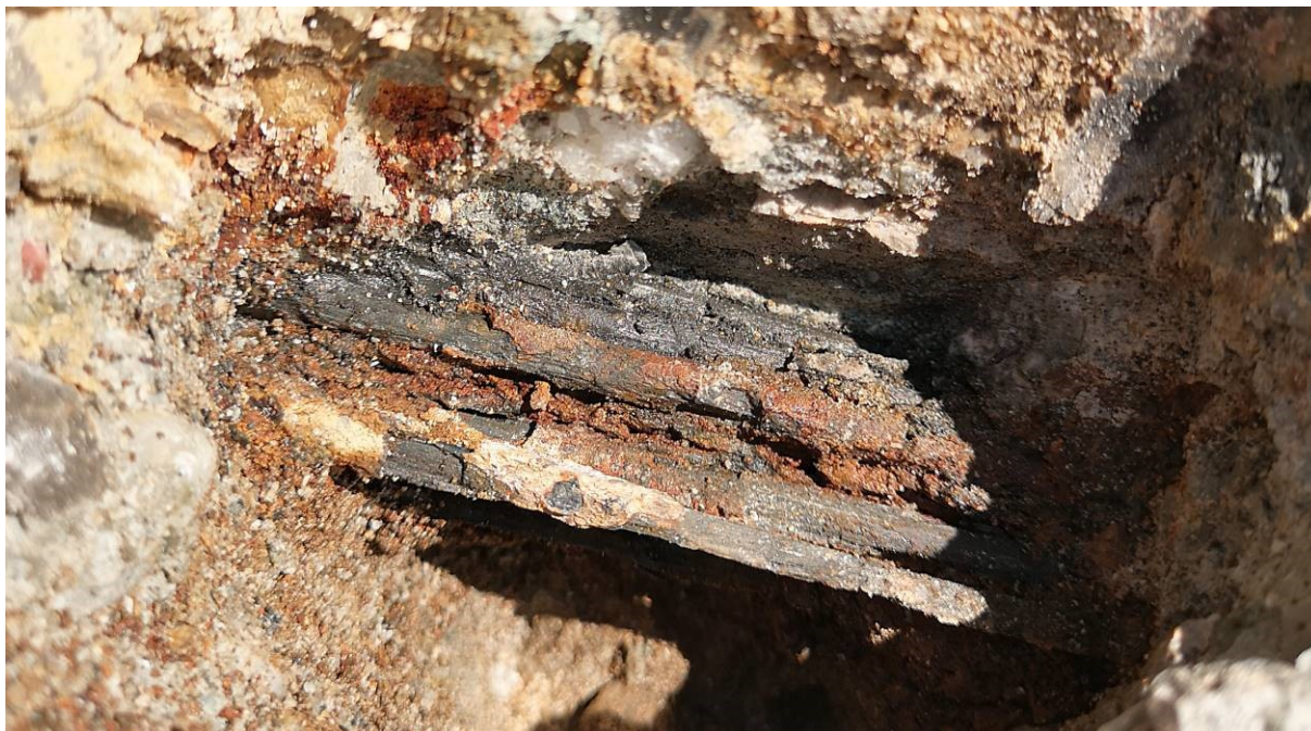
Obr.F41-S405 Sonda S39 do zvedaného kabelového kanálku předpjaté výztuže vedeného ve stojině nosníku č.8 ve třetím poli. Sonda provedena 4000 mm za začátkem nosníku a 630 mm nad podhledem nosníku,
