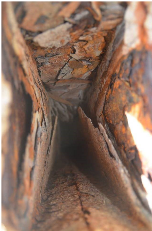
Obr.F41-56 Detail dutiny destrukčního zařízení v přední straně pravého sloupu třetí mezilehlé podpěry.
