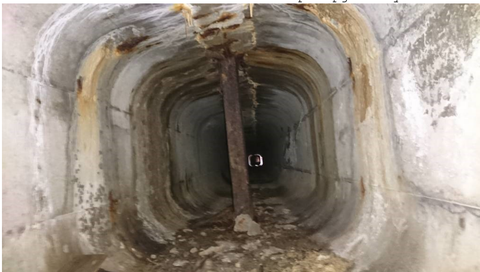
Obr.F41-526 Dutina mezi nosníky č.7 a č.8 ve třetím poli. Pohled skrz dilatační spáru mezi čely nosníků č.8 druhého a třetího pole nad 3. (mezilehlou) podpěrrou, ve směru staničení,
