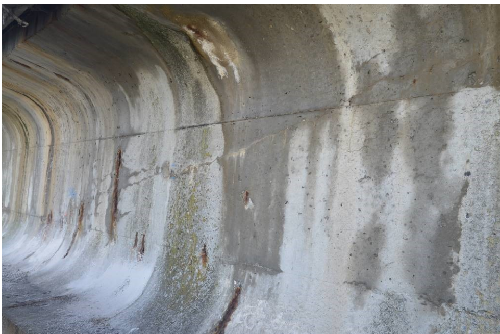
Obr.F41-41 Trhlina v místě zvedaného kabelového kanálku na levé fasádě (nosník č.1) ve dvou třetinách čtvrtého pole. Pohled ve směru staničení a zleva doprava (proti vodě),
