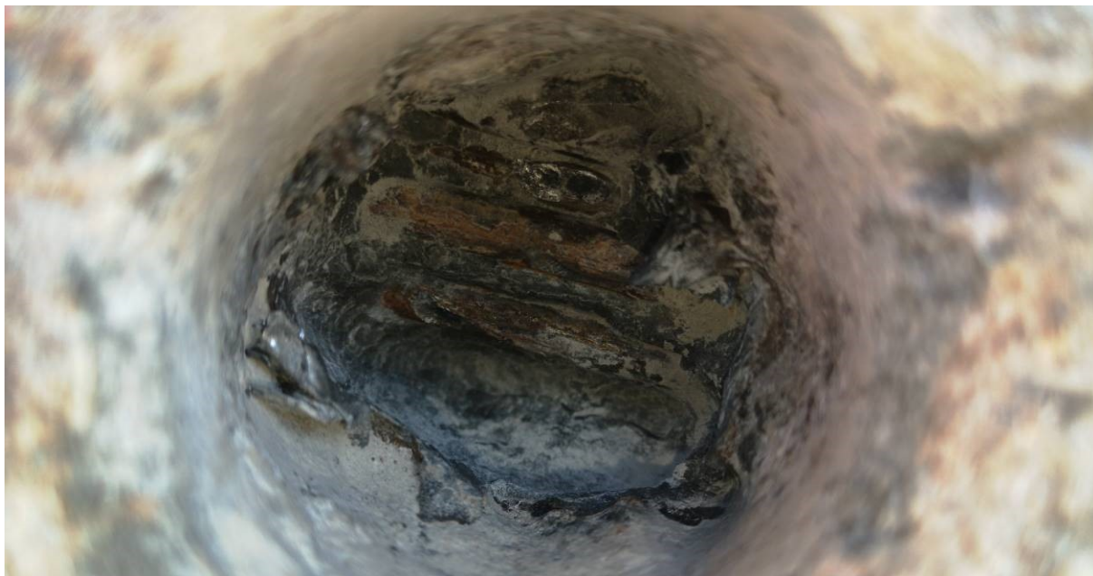
Obr.F41-403 Sonda S37 do zvedaného kabelového kanálku předpjaté výztuže vedeného ve stojině nosníku č.8 ve třetím poli . Sonda provedena 1570 mm za začátkem nosníku a 700 mm nad podhledem nosníku,
