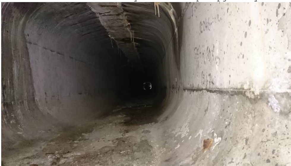
Obr.F41-510 Dutina mezi nosníky č.1 a č.2 ve druhém poli. Pohled skrz dilatační spáru mezi čely nosníků č.1 druhého a třetího pole nad 3. (mezilehlou) podpěrou, proti směru staničení,
