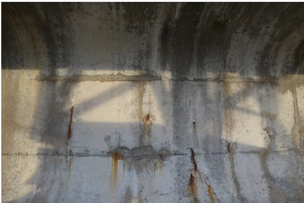
Obr.F41-44 Trhliny v místech vedení zvedaných kabelových kanálků na pravé fasádě nosníku č.8 ve třetině rozpětí čtvrtého pole. Pohled po vodě,
