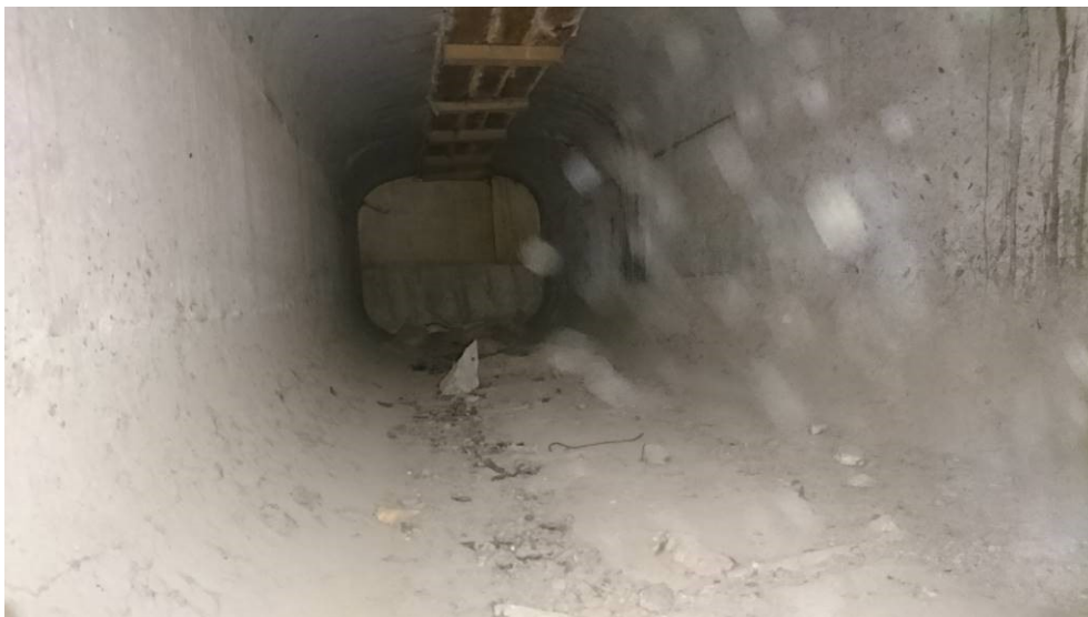
Obr.F41-518 Dutina mezi nosníky č.5 a č.6 ve čtvrtém poli. Pohled skrz prostup (otvor) v dolní přírubě nosníku č.5, ve směru staničení,
