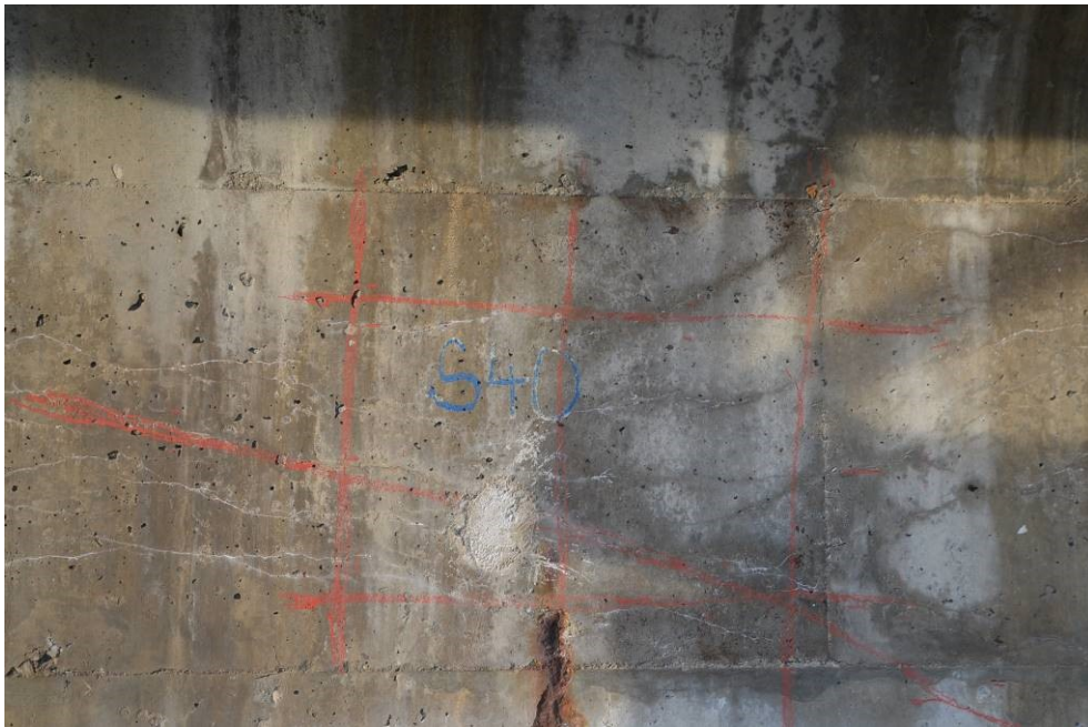
Obr.F41-45 Trhliny v místě vedení zvedaného kabelového kanálků na fasádní stěně nosníku č.8 na začátku čtvrtého pole. Pohled po vodě,
