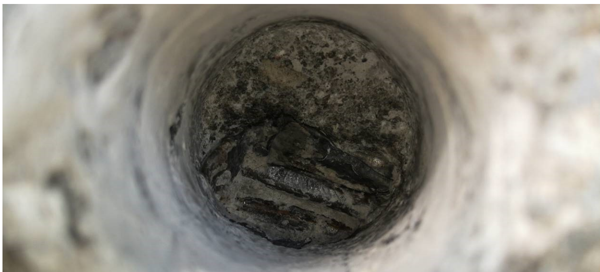
Obr.F41-401 Sonda S35 do zvedaného kabelového kanálku předpjaté výztuže vedeného ve stojině nosníku č.8 v prvním poli . Sonda provedena 2300 mm před příčnou spárou mezi prvním a druhým dílcem nosníku a 850 mm nad podhledem nosníku,
