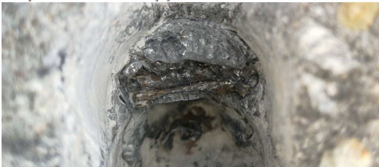
Obr.F41-404 Sonda S38 do zvedaného kabelového kanálku předpjaté výztuže vedeného ve stojině nosníku č.1 ve druhém poli . Sonda provedena 3150 mm za začátkem nosníku a 300 mm nad podhledem nosníku,
