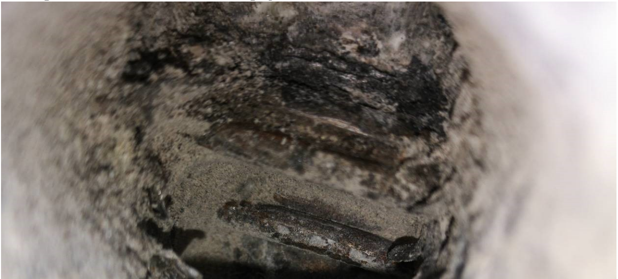
Obr.F41-408 Sonda S42 do zvedaného kabelového kanálku předpjaté výztuže vedeného ve stojině nosníku č.1 ve třetím poli . Sonda provedena 4400 mm za za příčnou spárou mezi druhým a třetím dílcem nosníku a 720 mm nad podhledem nosníku,
