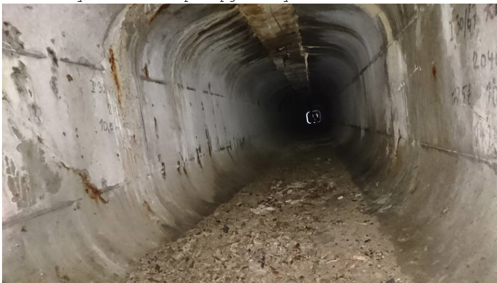
Obr.F41-516 Dutina mezi nosníky č.1 a č.2 ve čtvrtém poli. Pohled skrz dilatační spáru mezi čelem nosníku č.1 čtvrtého pole a ZZ 5. podpěry, letovické opěry, proti směru st.,
