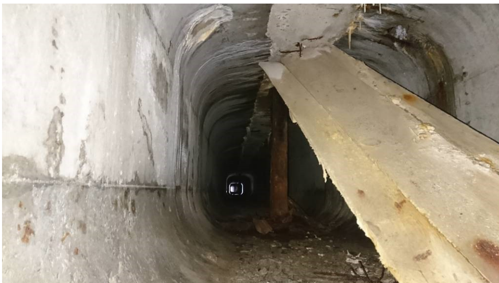
Obr.F41-511 Dutina mezi nosníky č.1 a č.2 ve třetím poli. Pohled skrz dilatační spáru mezi čely nosníků č.1 druhého a třetího pole nad 3. (mezilehlou) podpěrrou, ve směru staničení,
