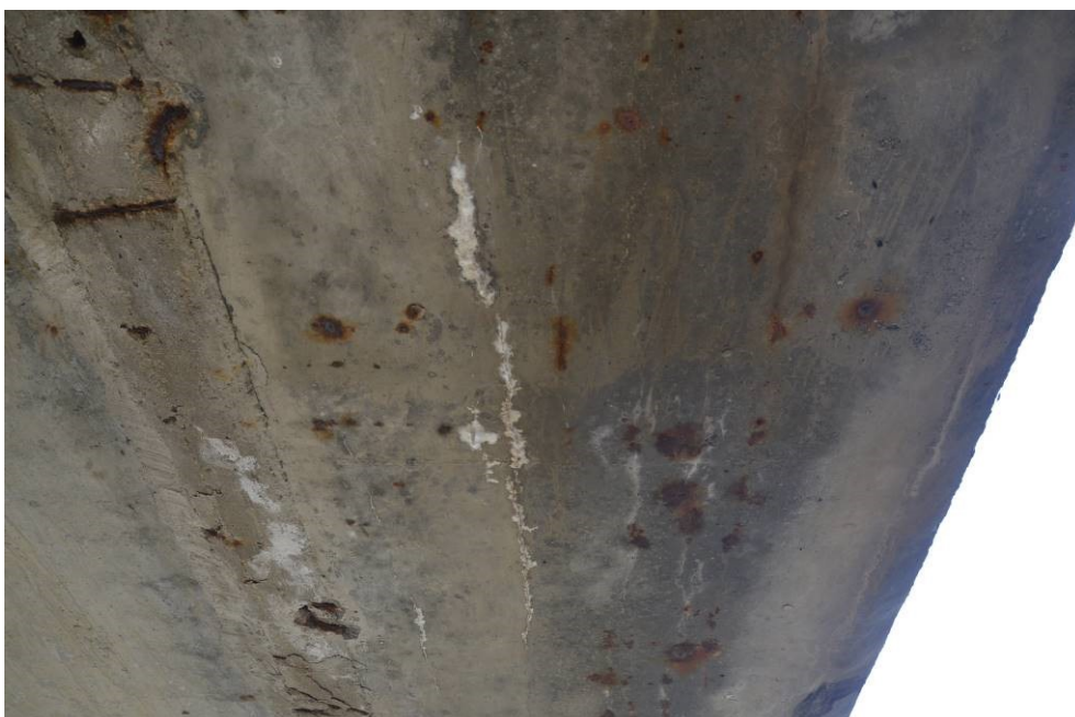
Obr.F41-42 Trhliny v místech vedení přímých kabelových kanálků na podhledu nosníku č.8 ve střední části prvního pole. Pohled ve směru staničení a vzhůru,
