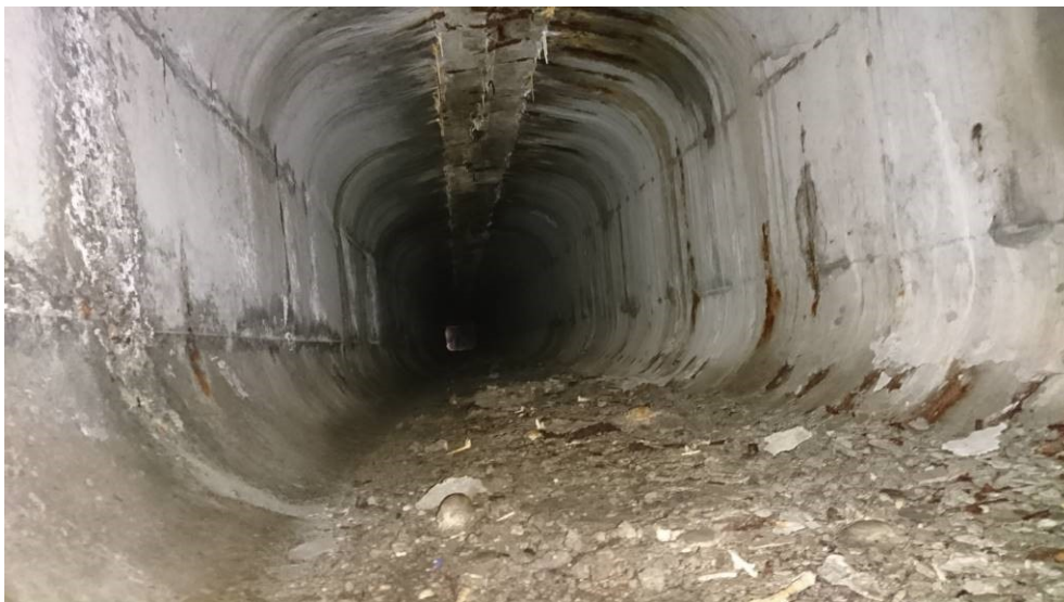
Obr.F41-519 Dutina mezi nosníky č.7 a č.8 v prvním poli. Pohled skrz prostup pro odpadní troubu mostního odvodňovače v dolní podélné spáře mezi nosníky, proti směru staničení,
