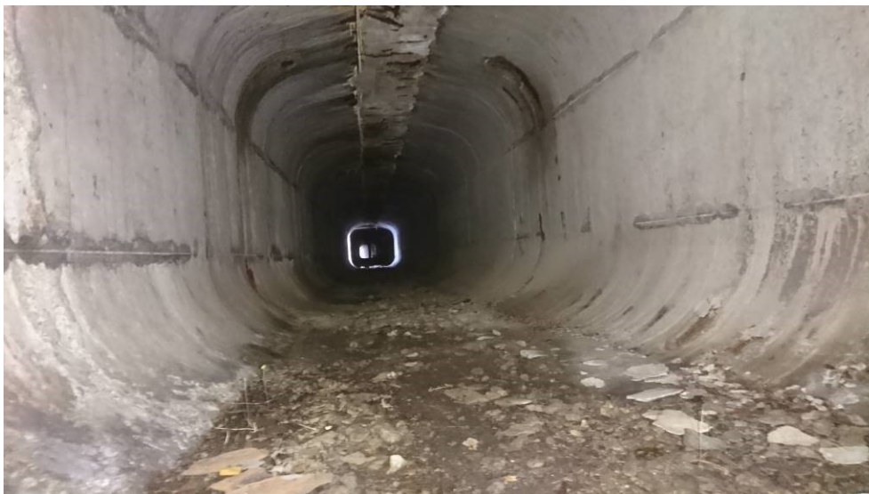
Obr.F41-513 Dutina mezi nosníky č.1 a č.2 ve třetím poli. Pohled skrz prostup pro odpadní troubu druhého mostního odvodňovače třetího pole v dolní podélné spáře mezi nosníky, ve směru staničení,
