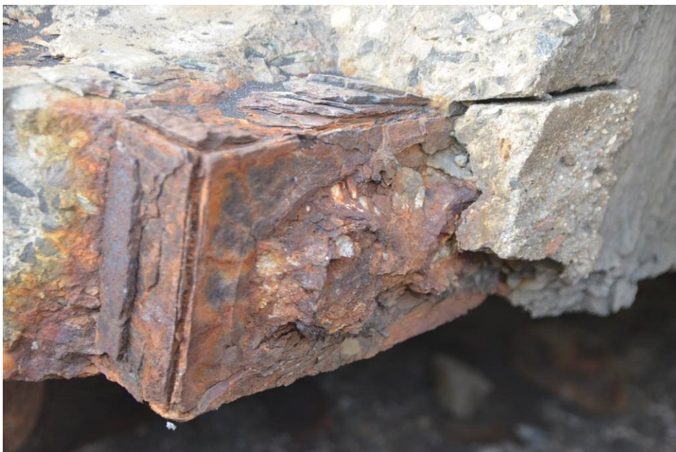
Obr.F41-49 Dvojkotva přímých kabelů na čele dolní příruby nosníku č.8 na konci třetího pole. Pohled proti směru staničení a zprava doleva (po vodě),
