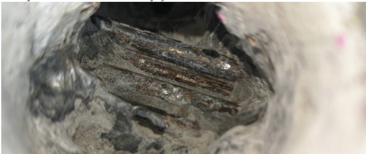
Obr.F41-410 Sonda S44 do zvedaného kabelového kanálku předpjaté výztuže vedeného ve stojině nosníku č.1 ve čtvrtém poli . Sonda provedena 2800 mm za začátkem nosníku a 500 mm nad podhledem nosníku,
