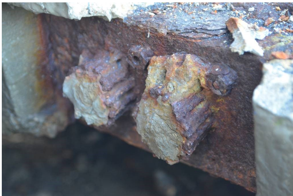
Obr.F41-48 Dvojkotva přímých kabelů na čele dolní příruby nosníku č.1 na konci třetího pole. Pohled zleva doprava (proti vodě) a proti směru staničení,
