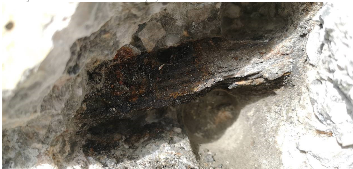
Obr.F41-402 Sonda S36 do zvedaného kabelového kanálku předpjaté výztuže vedeného ve stojině nosníku č.8 v prvním poli . Sonda provedena 2200 mm za příčnou spárou mezi druhým a třetím dílcem nosníku a 750 mm nad podhledem nosníku,
