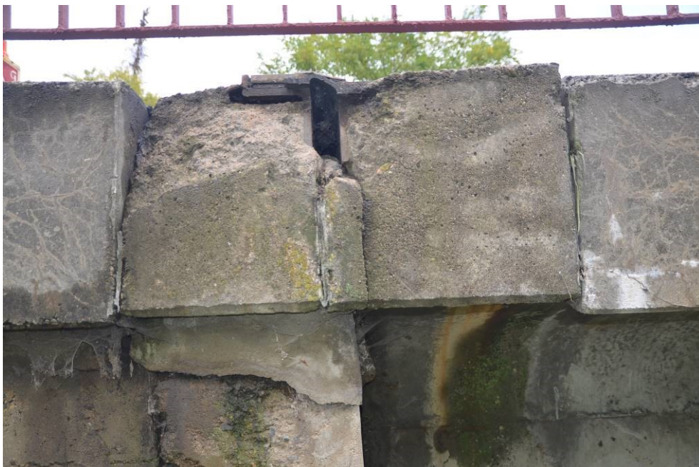
Obr.F41-57 Mostní závěr v pravé římse nad první podpěrou, křetínskou opěrou. Pohled zprava doleva. Stav před poslední sanací,
