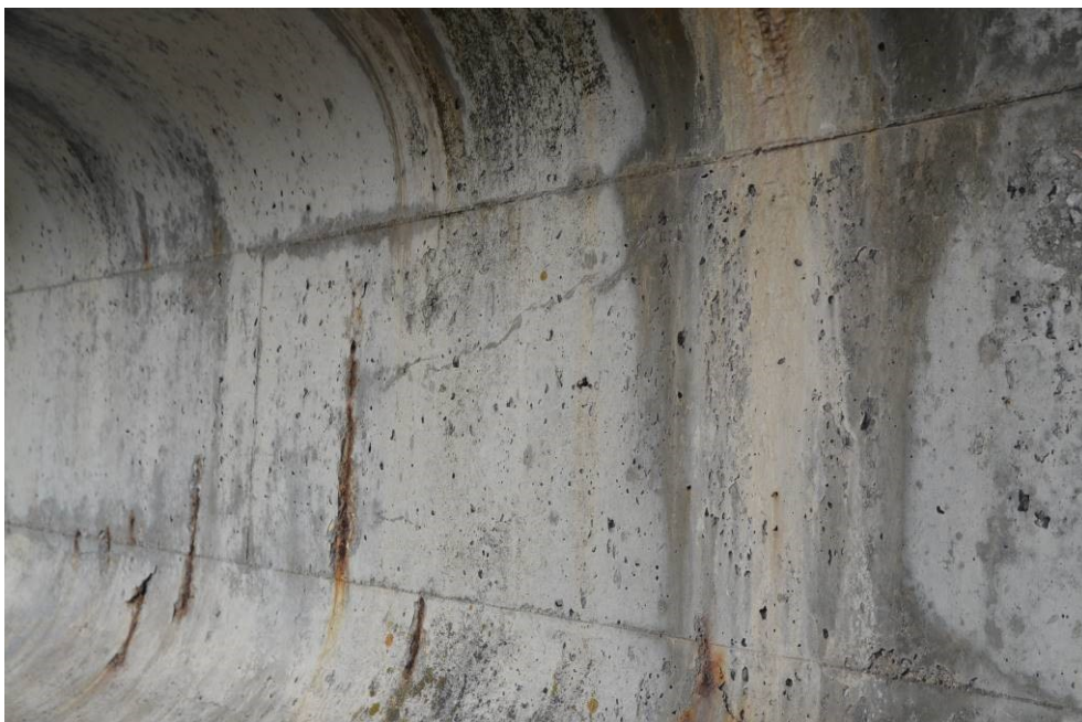
Obr.F41-46 Trhлина v místě vedení zvedaného kabelového kanálku na pravé fasádě nosníku č.8 na konci prvního pole. Pohled proti směru staničení a po vodě,
