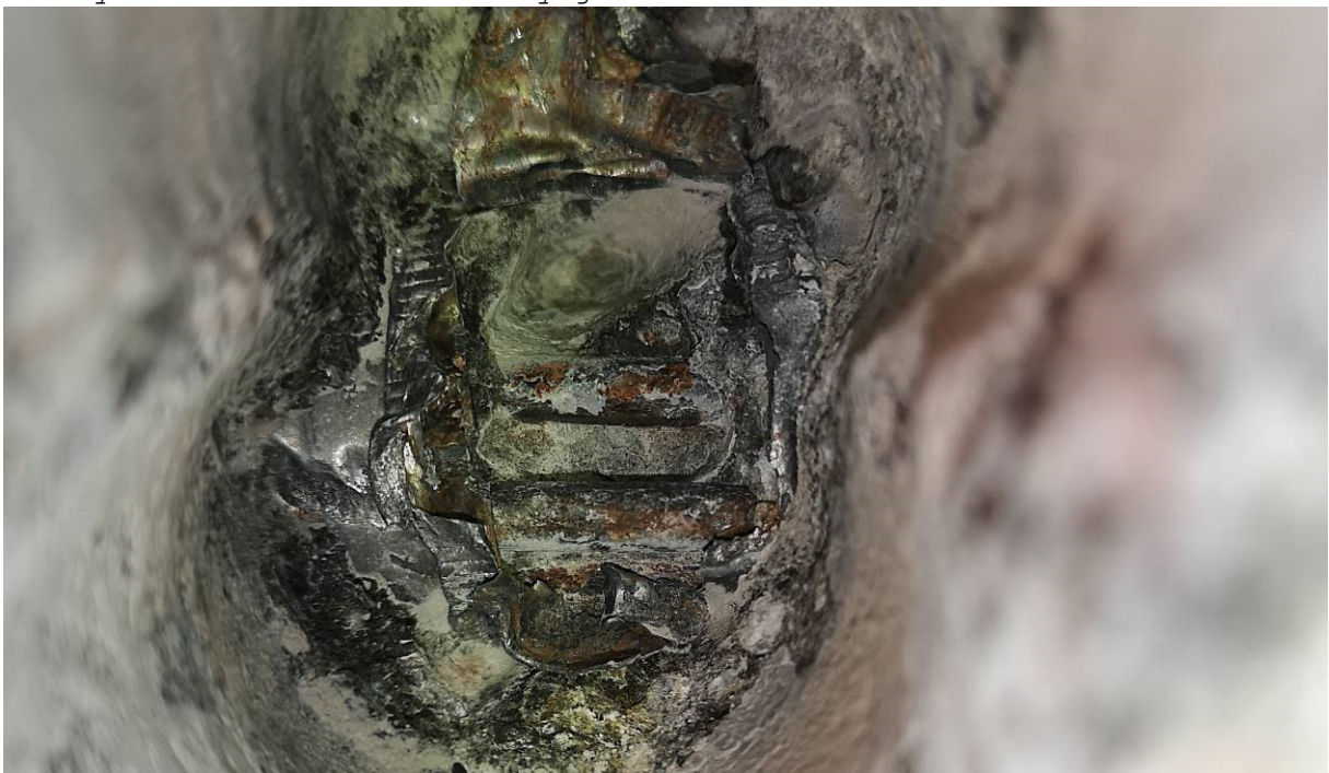
Obr.F41-412 Sonda S46 do přímého kabelového kanálku předpjaté výztuže vedeného v dolní přírubě nosníku č.8 ve čtvrtém poli. Sonda provedena 1560 mm za příčnou spárou mezi prvním a druhým dílcem nosn. a 350 mm od pravého líce nosn. č.8,
