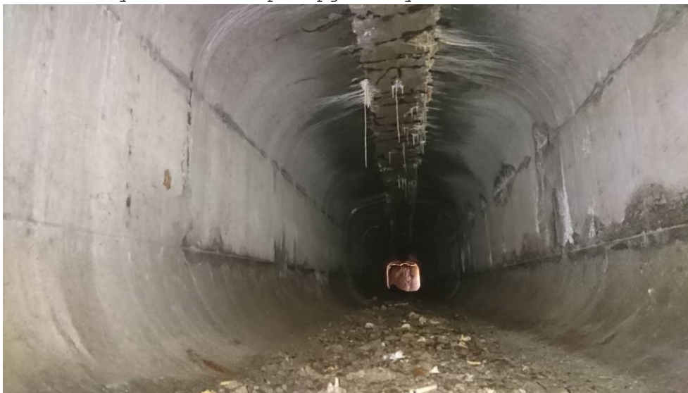
Obr.F41-530 Dutina mezi nosníky č.7 a č.8 ve čtvrtém poli. Pohled skrz prostup pro odpadní troubu mostního odvodňovače v dolní podélné spáře mezi nosníky, ve směru staničení,
