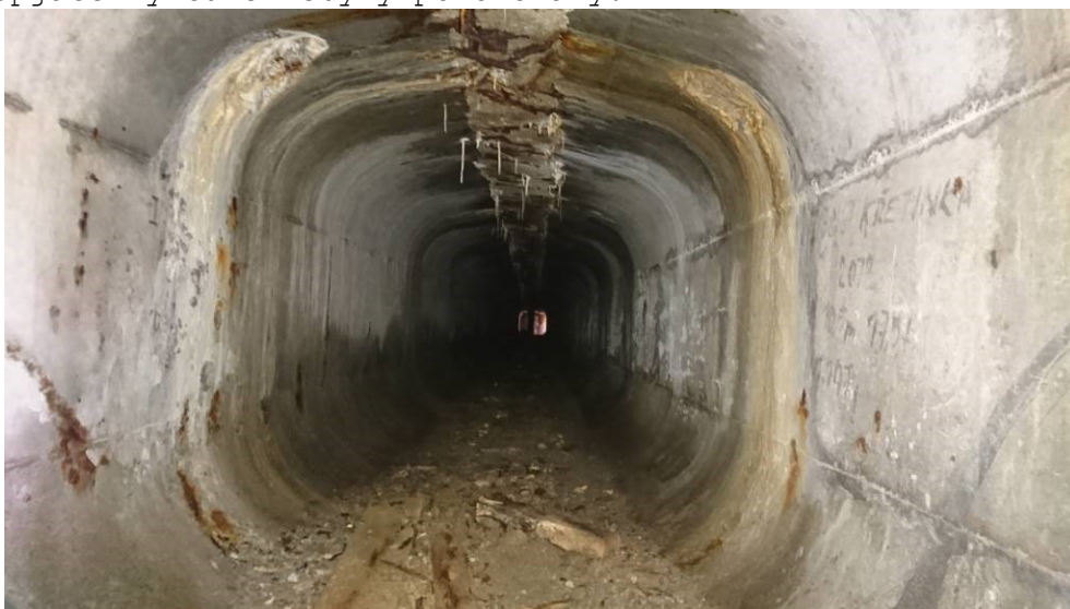
Obr.F41-528 Dutina mezi nosníky č.7 a č.8 ve čtvrtém poli. Pohled skrz dilatační spáru mezi čely nosníků č.8 třetího a čtvrtého pole nad 4. (mezilehlou) podpěrrou, ve směru staničení,
