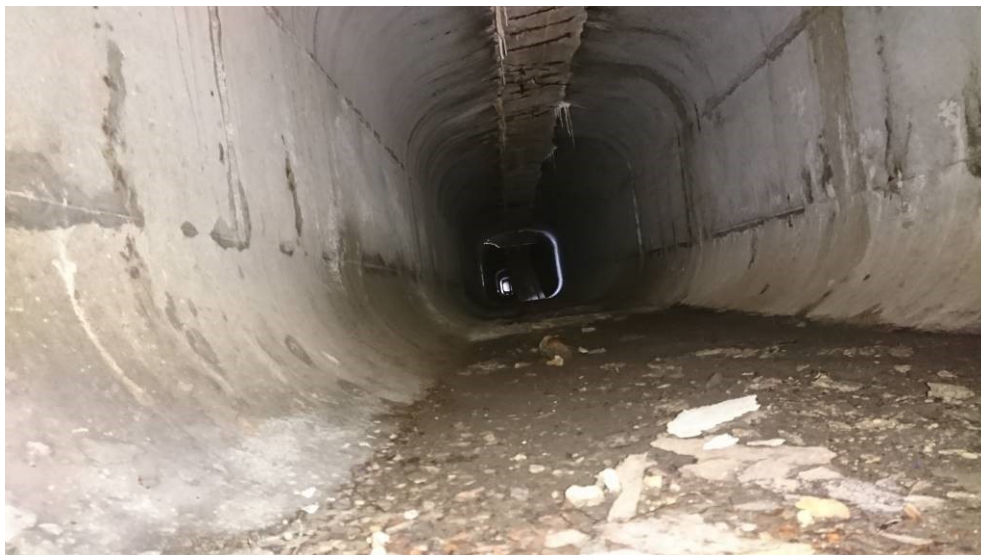
Obr.F41-509 Dutina mezi nosníky č.1 a č.2 ve druhém poli. Pohled skrz prostup pro odpadní troubu druhého mostního odvodňovače druhého pole v dolní podélné spáře mezi nosníky, ve směru staničení,
