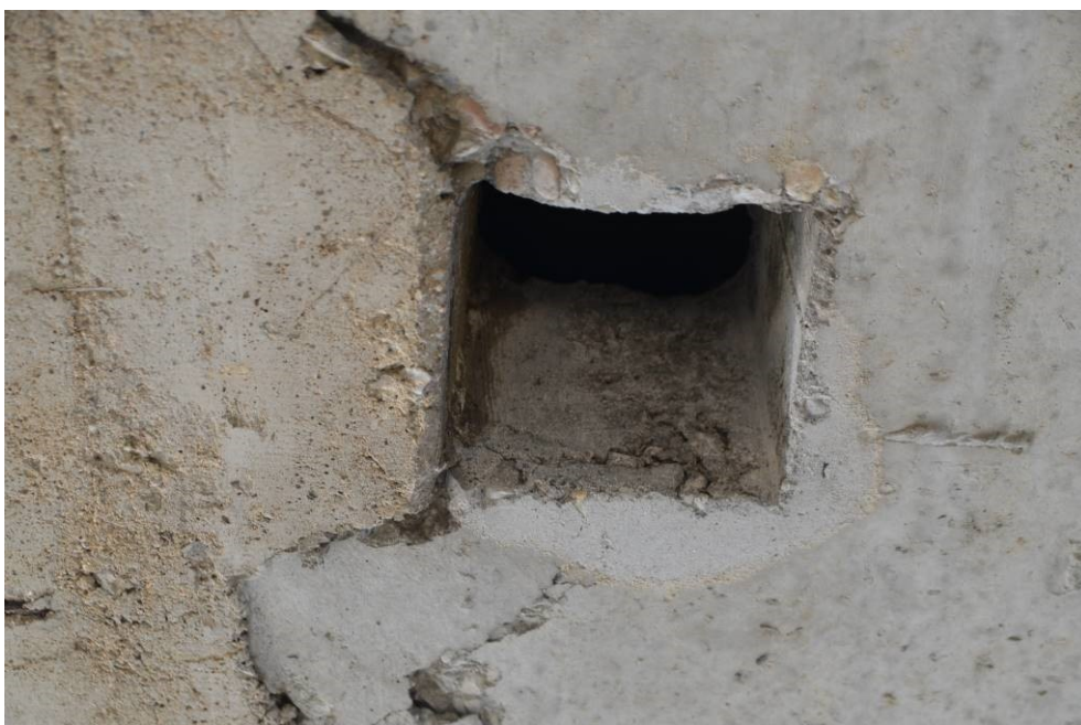
Obr.F41-52 Chybné umístění nosníku (č.5) s otvorem pro odpadní troubu odvodňovače ve čtvrtém poli. Detail,
