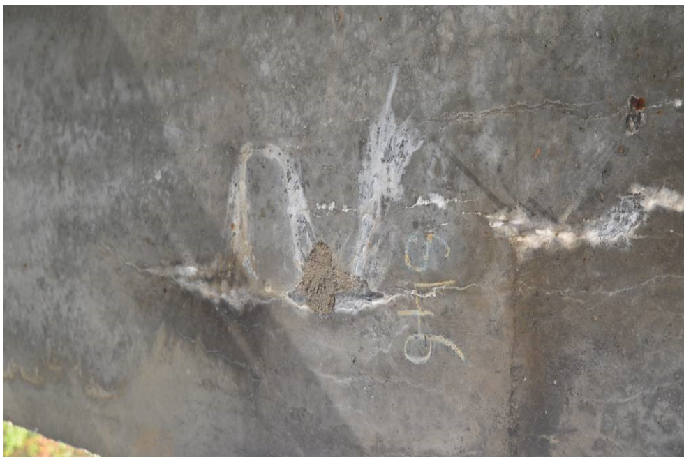
Obr.F41-43 Trhliny v místech vedení přímých kabelových kanálků na podhledu nosníku č.8 ve třetině rozpětí čtvrtého pole. Detail.
