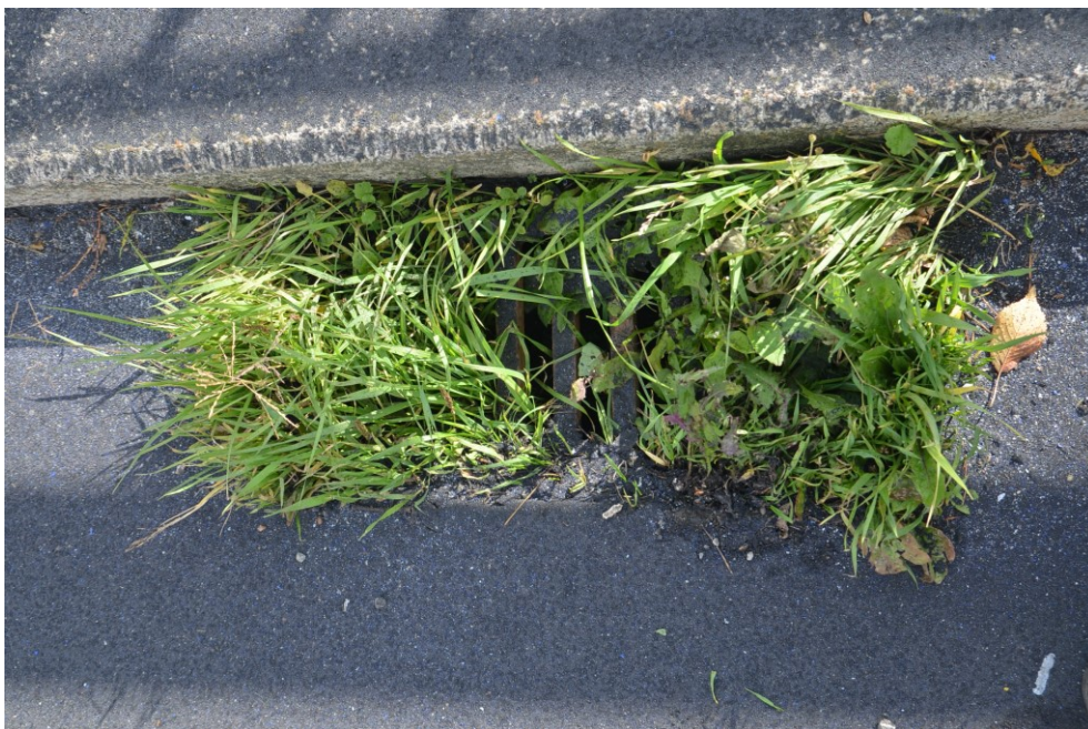
Obr.F41-61 Typický stav vtoku do mostního odvodňovače na mostě. Zde pravostranný odvodňovač v prvním poli,
