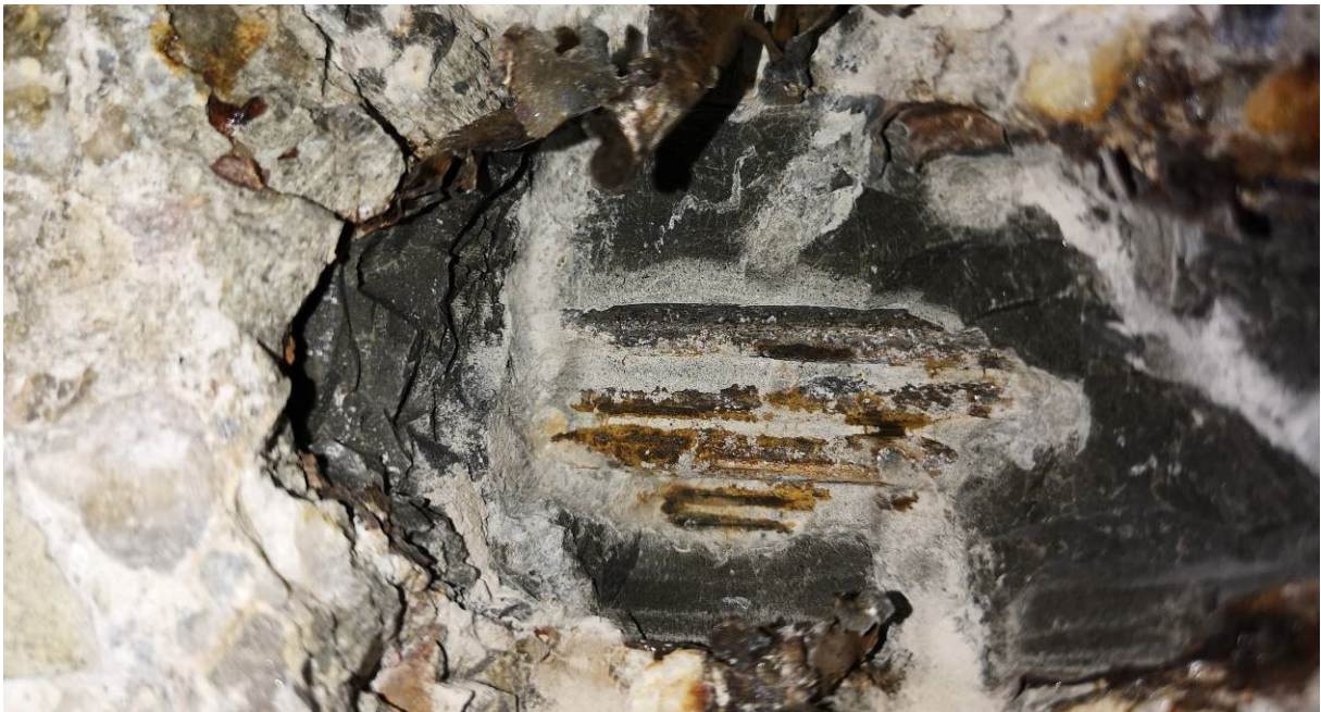
Obr.F41-407 Sonda S41 do přímého kabelového kanálku předpjaté výztuže vedeného v dolní přírubě nosníku č.1 ve druhém poli . Sonda provedena 3500 mm před lícem 3. (mezilehlé) podpěry a 800 mm od levého líce dolní příruby nosníku,
