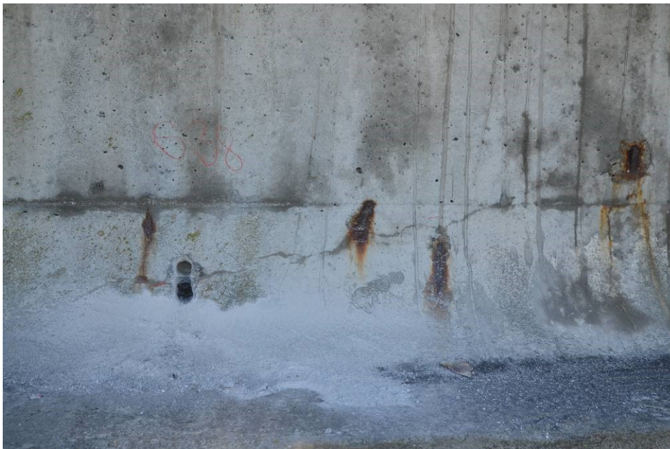
Obr.F41-39 Trhlina v místě zvedaného kabelového kanálku na levé fasádě (nosník č.1) na začátku druhého pole. Pohled zleva doprava (proti vodě),
