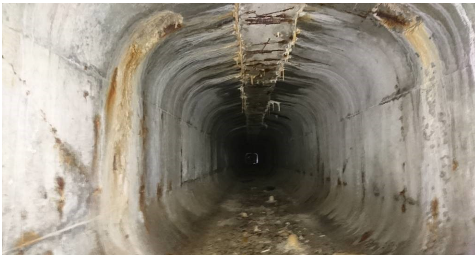
Obr.F41-527 Dutina mezi nosníky č.7 a č.8 ve třetím poli. Pohled skrz dilatační spáru mezi čely nosníků č.8 třetího a čtvrtého pole nad 4. (mezilehlou) podpěrrou, proti směru staničení,
