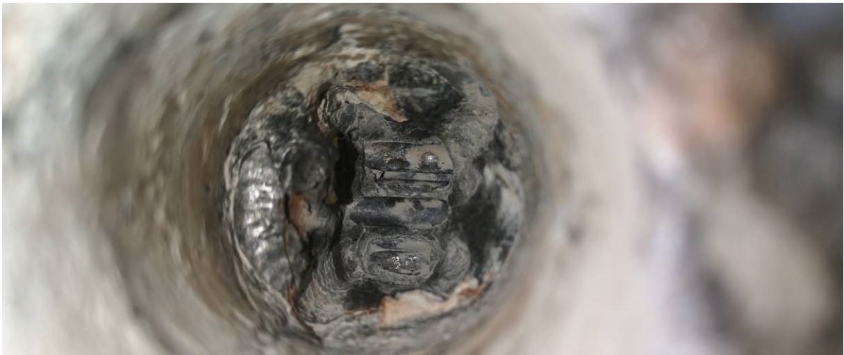
Obr.F41-411 Sonda S45 do přímého kabelového kanálku předpjaté výztuže vedeného v dolní přírubě nosníku č.2 ve čtvrtém poli. Sonda provedena v příčné spáře mezi druhým a třetím dílcem nosníku a 2040 mm od levého líce nosníku č.1,
