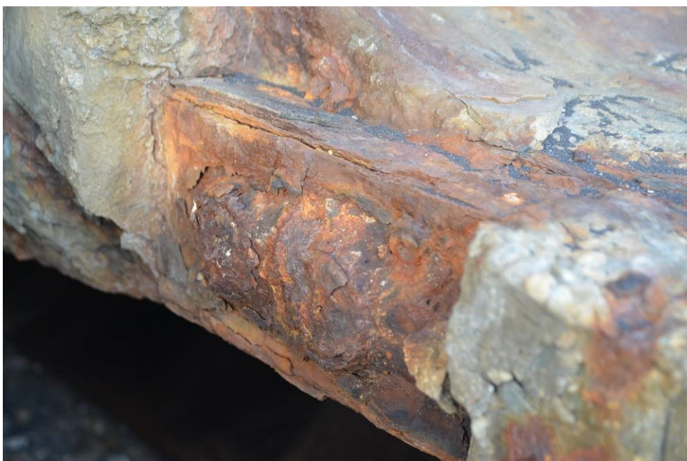
Obr.F41-50 Dvojkotva přímých kabelů na čele dolní příruby nosníku č.8 na začátku čtvrtého pole. Pohled zprava doleva (po vodě) a ve směru staničení,
